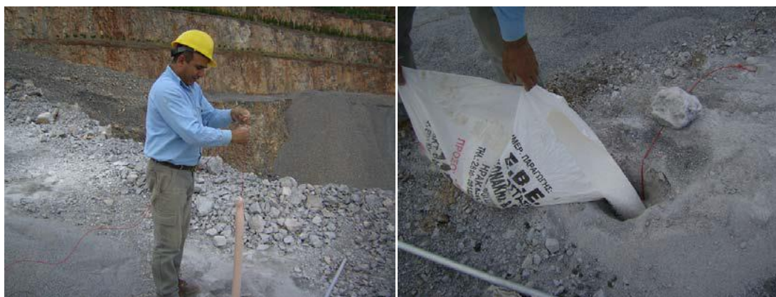
Σχήμα 5: Γόμωση διατρημάτων με φυσίγγια και ANFO.
